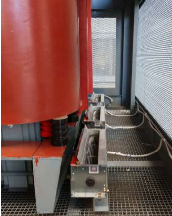
Imagen Transformador Seco Encapsulado IMESA con ventilación Forzada
